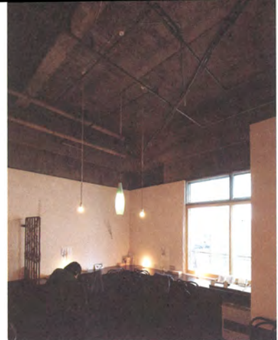
三誠ビル1階のカフェの天井に当時のRC打放しを見ることができる
