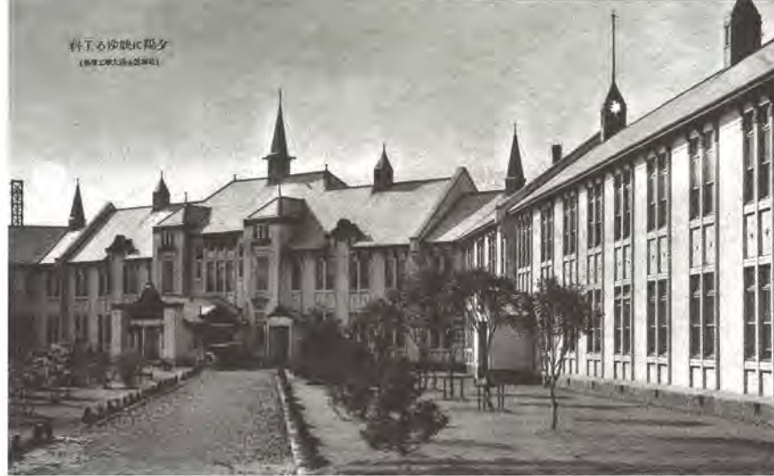
北海道帝国大学工学部本館外観 (北海道大学附属図書館所蔵)
